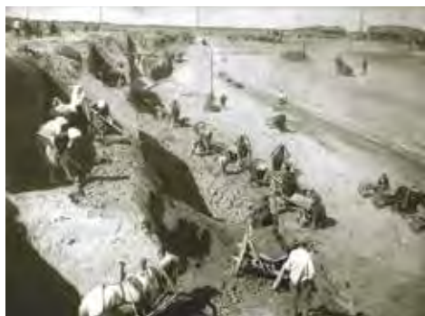
Kubikosok a Dnyeperi Vízzerőmű alapjának ásásánál, 1930.
